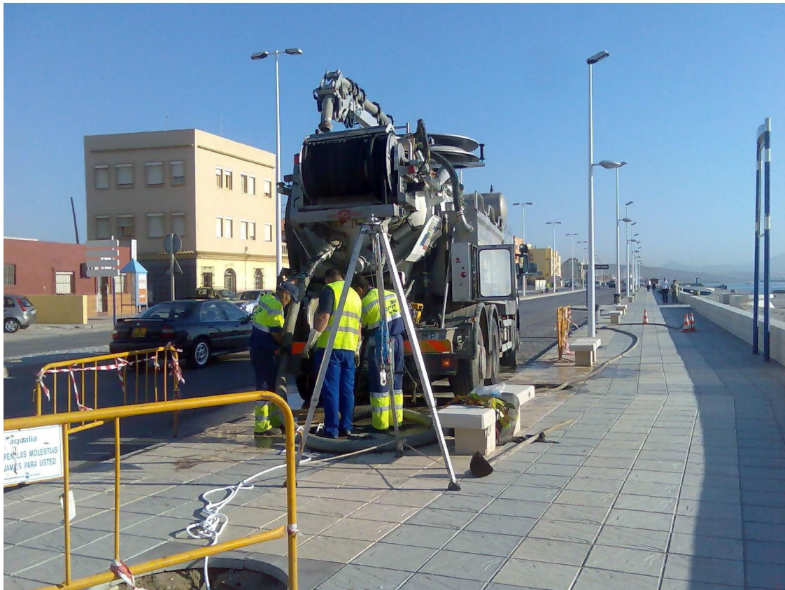
Trabajadores de Aqualia en el Paseo de Levante de La Línea.
