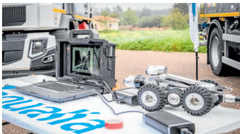
La cámara teledirigida conectada al monitor que se meterá en la red de tuberías de Mérida. HOY
