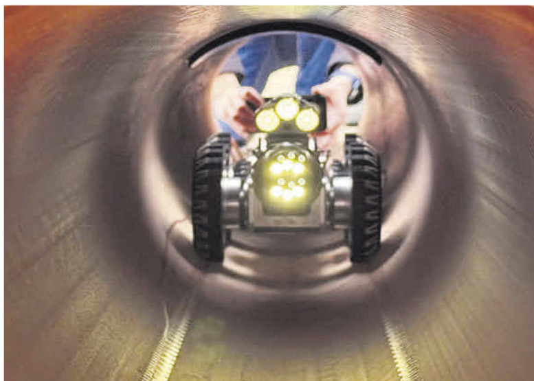
Aqualia se dota de un robot que recorrerá el interior de la red de saneamiento.
